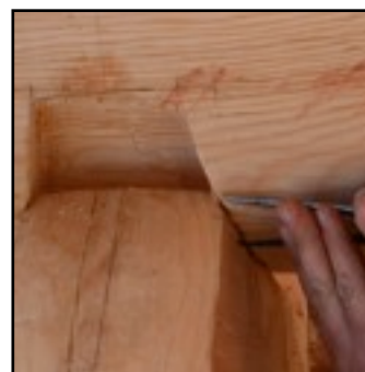
Oppmerking. Underside av veggstokk under arbeid.
