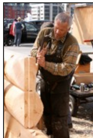
Hogging av tapp, og spissing mot beitski
