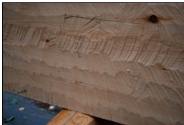
Oppmerking av svill på langvegg
