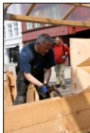
Hogging av tapphull for beitski. Foto: Bjørn Systad
