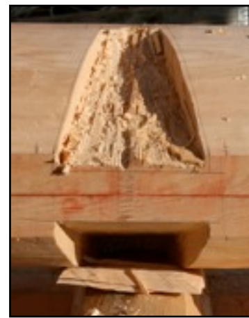
Oppmerking. Underside av veggstokk under arbeid.
