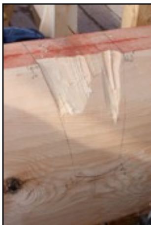
Oppmerking. Underside av veggstokk under arbeid.
