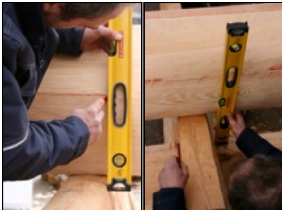
Overføring av merker. Veggstokk mot svill.
