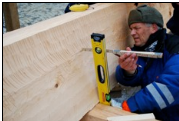
Overføring av mål til oppmerking av svill.
