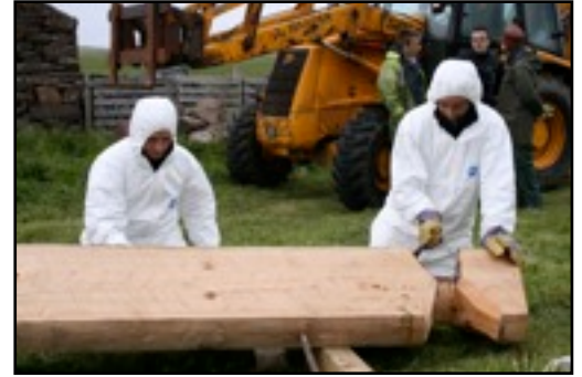
Tømmeret blir behandlet med tjære mens de legges på plass.
