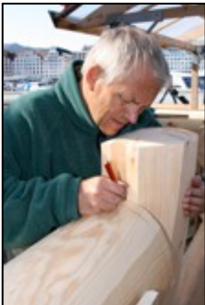
Oppmerking for tapp mot beitski. Hans Marumsrud.
