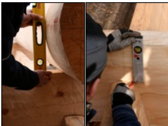
Overføring av merker. Veggstokk mot svill.
