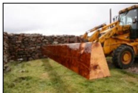
Svillen blir lagt på plass.
