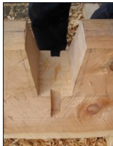
Hogg med spor for låsetapp, svill i kortvegg Foto: Bjørn Systad
